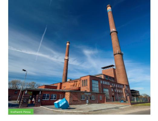
Das Kraftwerk ist inzwischen in seiner Technik annähernd auf den Zustand zurückgebaut, den es um 1927/28 hatte. Neben den Maschinen beeindruckt auch die Ästhetik des Gebäudes – ein Stahlskelettbau mit Klinkerverblendung, der bei aller Funktionalität eine ruhige Eleganz ausstrahlt. Zehn Minuten Fußweg sind es vom Kraftwerk zum Standort der ehemaligen Förderbrücke. An einem sonnigen Septembertag 1924 nahm sie den Betrieb auf, stand 1958 still und wurde ein Jahr darauf verschrottet.
